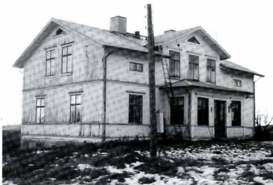
Mangårdsbyggnad, Ala 1:8. Foto 1989/6:18.
