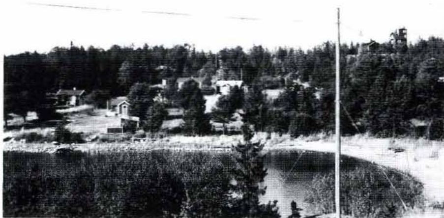
Storhamns lotsstation med lots- och fiskarstugor. I bildens högra kant syns lotstornet. Foto 1994/4.
