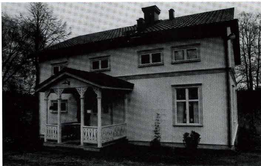
Mangårdsbyggnad, Risgrändsbyn 1:3. Foto 1991/21:34.
