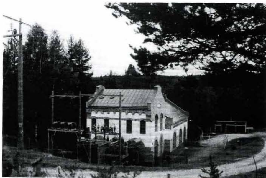
Rundbackens kraftverk, Västra roten 1:7. Foto 1983/18:2.
