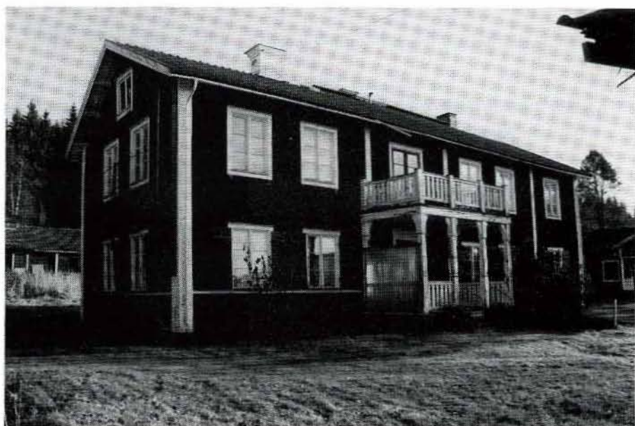
Mångårdsbyggnad av parstugetypp med framkammare, Stavre 1:66. Foto 1991/20:6.
