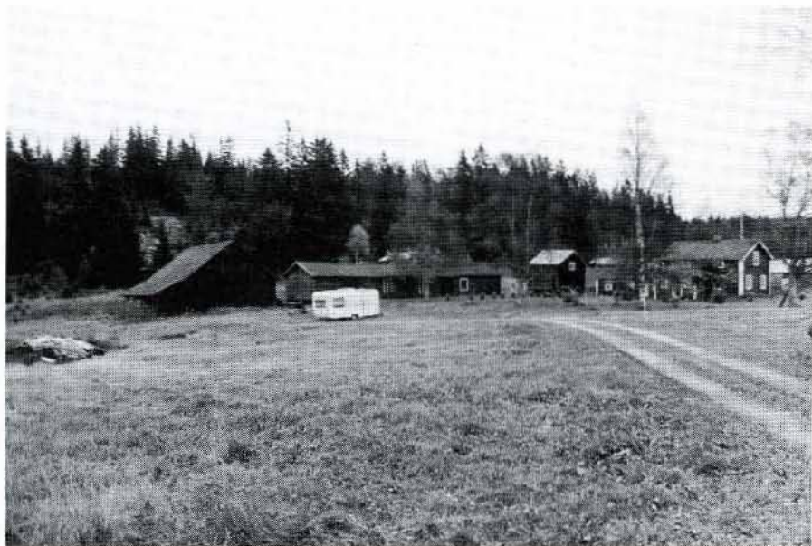
Jordbruksfastighet, Bäräng 2:2. Foto 1991/16:19.
