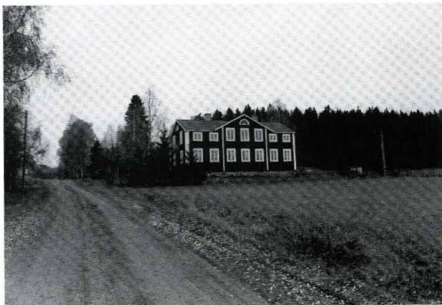
Mångårdsbyggnad, Hamre 2:20. Foto 1991/13:35.
