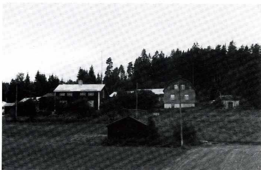
Jordbruksfastighet, Risgrändsbyn 1:2. Foto 1983/13:31.
