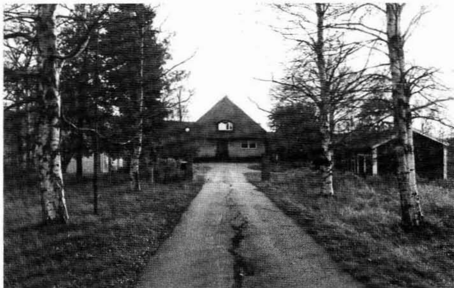
Gårdsuppfart till Östrands disp.bostad, Östrand 19:5. Foto 1986/7:2.
