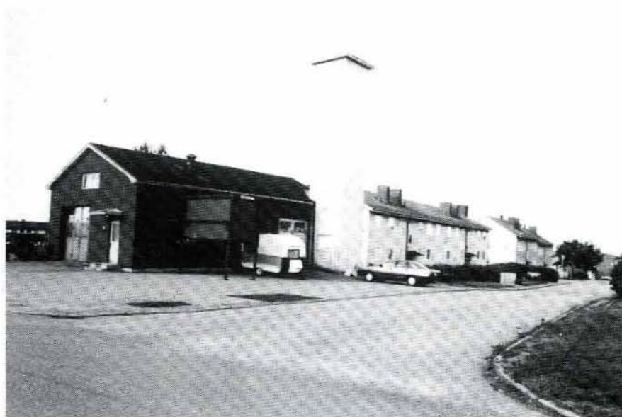
F. d. brandstation och flerbostadshus från 1950-talet. Foto 1991/5.
