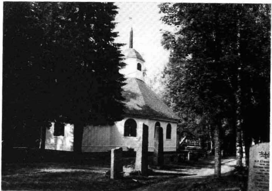
Lögdö kapell, uppfört 1717 av Mattias Krapp. Kapellet och kyrkogården är ett väsentligt inslag i den riksintressanta järnbruksmiljön vid Lögdö bruk. Foto 1985/2:7.
