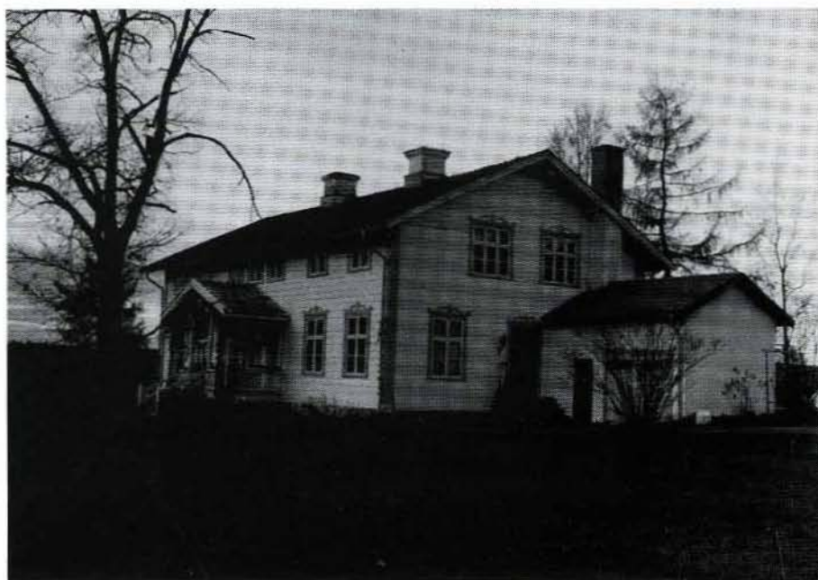
Mangårdsbyggnad, Fjäl, 1:37. Foto 1991/19:13.
