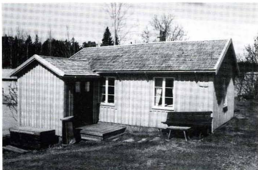
Under 1994 försågs alla fiskarstugorna med nya fasadpaneler och nya spåntak. Foto 1994/1.
