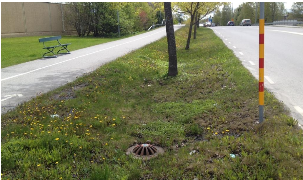
Bild 8. Exempel på svackdike i Östersund. Svackdiket avslutas i en kupolbrunn, som kan upphöjas för att skapa ytterligare fördröjningsvolym. Foto: Rickard Olofsson, Sweco.
