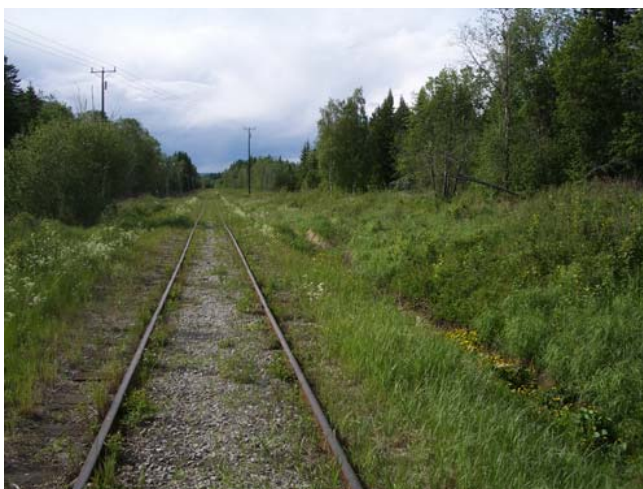
Industrispåret med porten under E4
